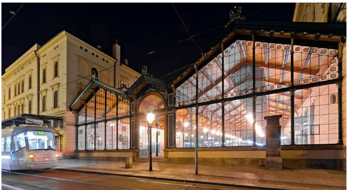
Obr. 18 Průčelí do Havlíčkovy ulice (Penta Investments).
